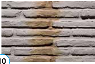
10 Počkáme na zaschnutie spojovacieho tmelu
