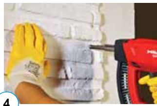
4 Panel pripevníme pomocou klincov
