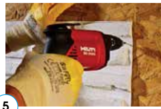
5 Panel pripevníme pomocou skrutiek
