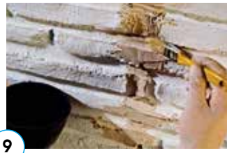
9 Tmel tvarujeme do tvaru štetcom a stierkovým nožom
